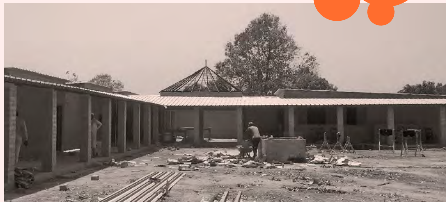
I lavori all'asilo sono quasi conclusi
