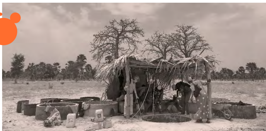
Scavo del pozzo a Silinkine
