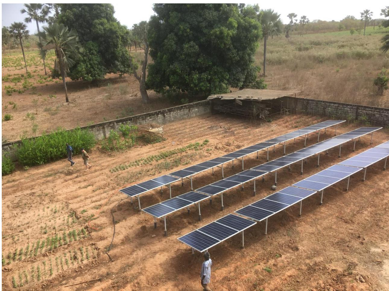
Pannelli solari fotovoltaici che alimentano la pompa solare per l'acquedotto di Oulampane
