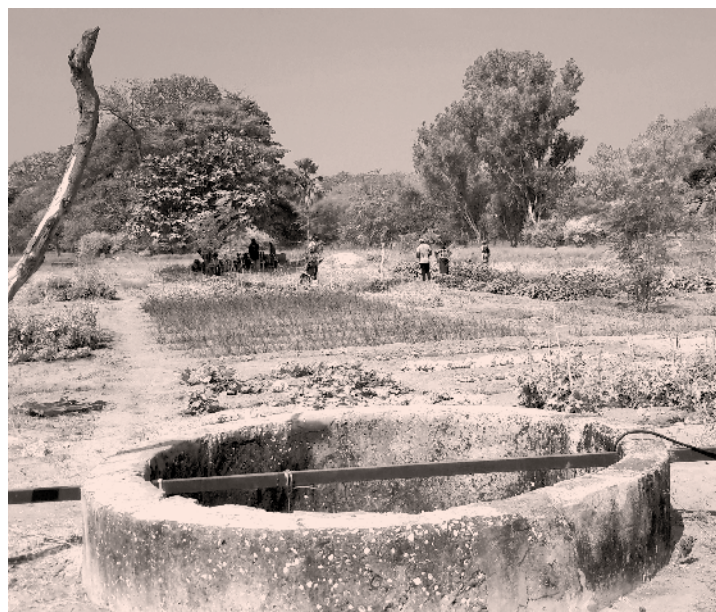
Il pozzo di Hassouka, che sarà oggetto di lavori di riparazione e di ripristino
